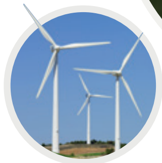
In wind mill industry In der Windkraftindustrie Inom vindkraftsindustrin
